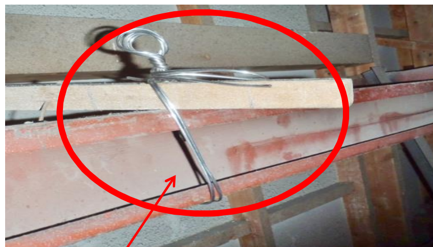
斜壁部分結束
